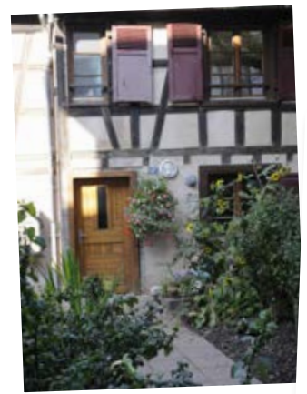
Cour des Zouaves - Centre (1980)
