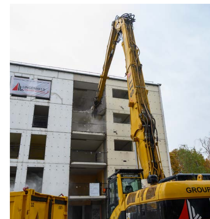
11 boulevard Lafontaine Démolition de 10 logements
