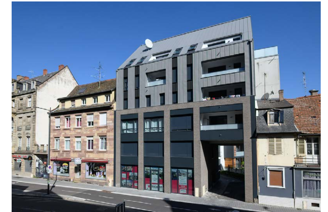
Route du Polygone à Strasbourg Neudorf VEFA de 13 logements
