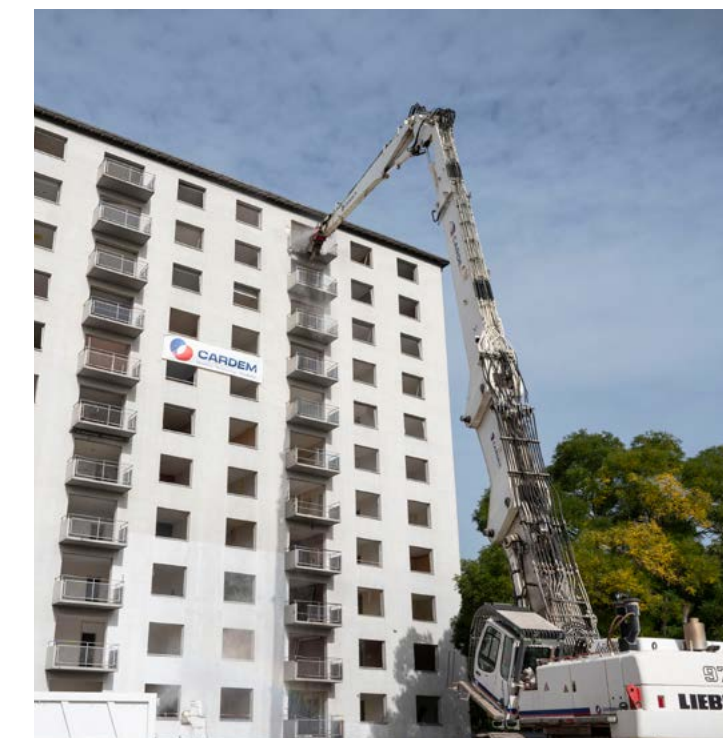
89 route du Neuhof Démolition de 66 logements
