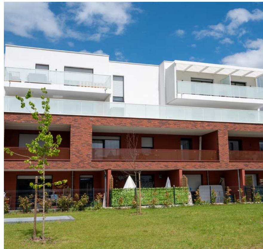
Epide - Rue du Général Picquart à Strasbourg VEFA de 13 logements
