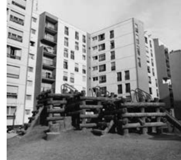
Maille Catherine en fin de chantier, accessoires de jeux. 1975
