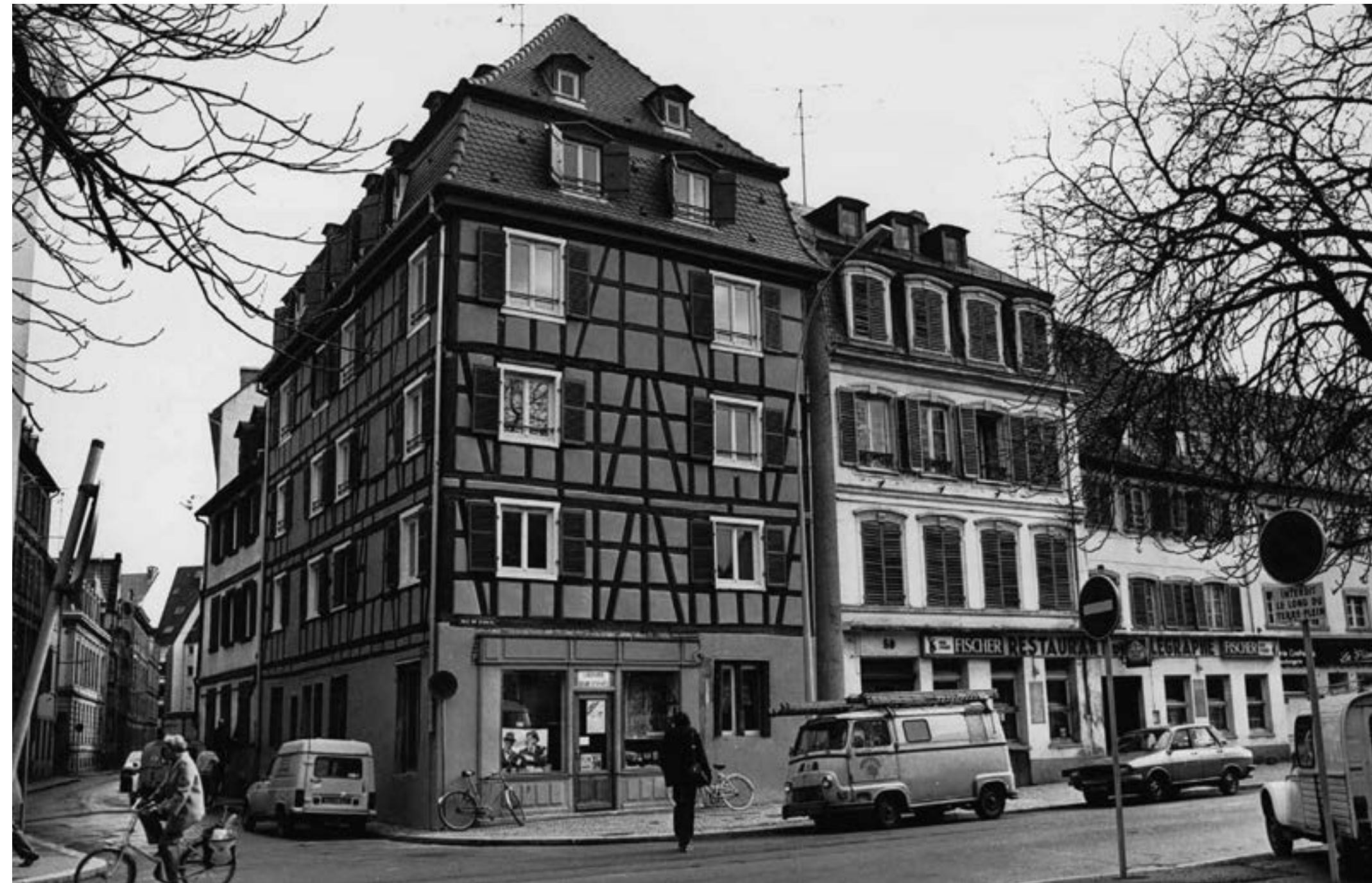
2 rue Fritz, vue sur le bâtiment après réhabilitation. 1981
