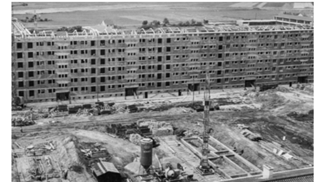
Cité de la Meinau, vue aérienne de la construction des bâtiments n°16 à 26 avenue de Normandie. 1957
