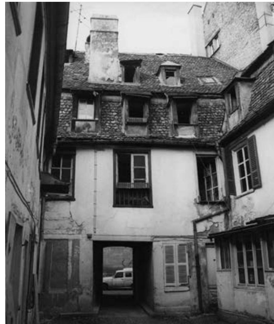
Rue des Poules avant et après réhabilitation. 1983-1984
