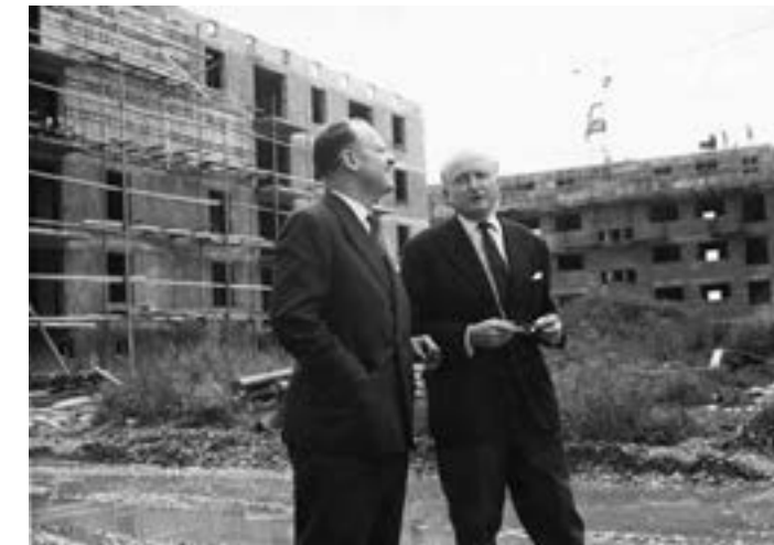
Cité de la Meinau, visite du chantier en présence de M. Gustave Stoskopf (droite) et M. Alexandre Jesel (gauche). 1961
