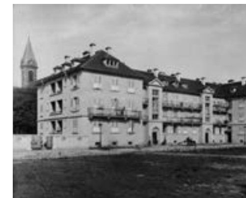
Vue extérieure d'un bâtiment, rue Jules Siegfried, à la fin du chantier de construction. 1928
