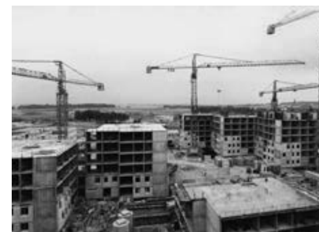
Maille Karine, vue d'ensemble en début de chantier. 1974
