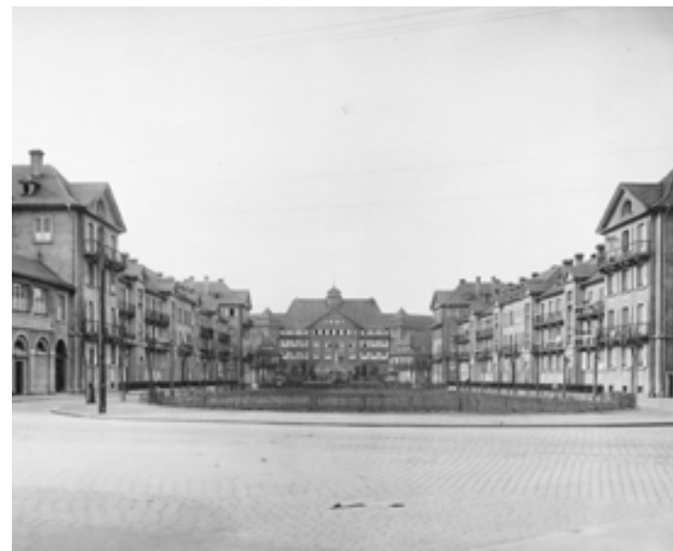
Cité Jules Siegfried, vue de l'Allée de l'Orphelinat à la fin du chantier de construction. 1928
