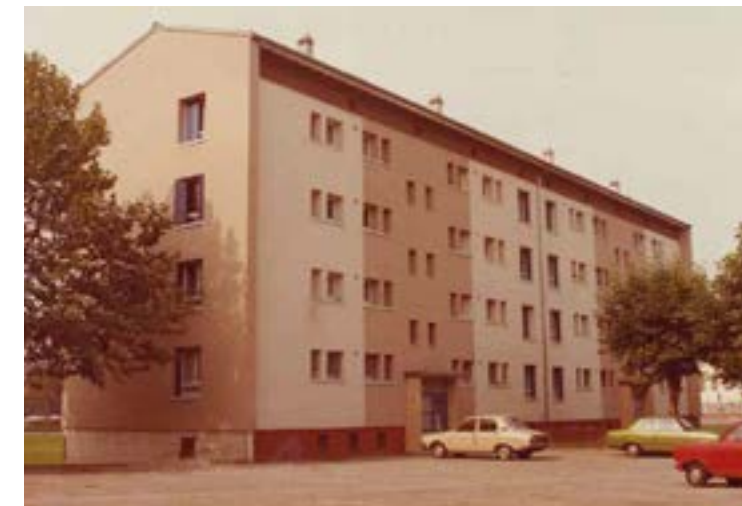
Route du Neuhof, vue extérieure d'un bâtiment réhabilité dans le cadre du programme « Habitat et Vie Sociale ». 1984
