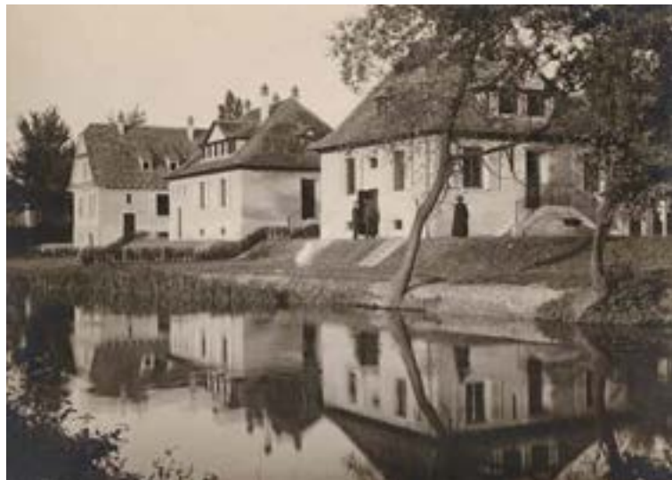
Maisons individuelles de la cité-jardins Ungemach, au bord de l'eau. Architectes Paul de Rutté et Jean Sorg
