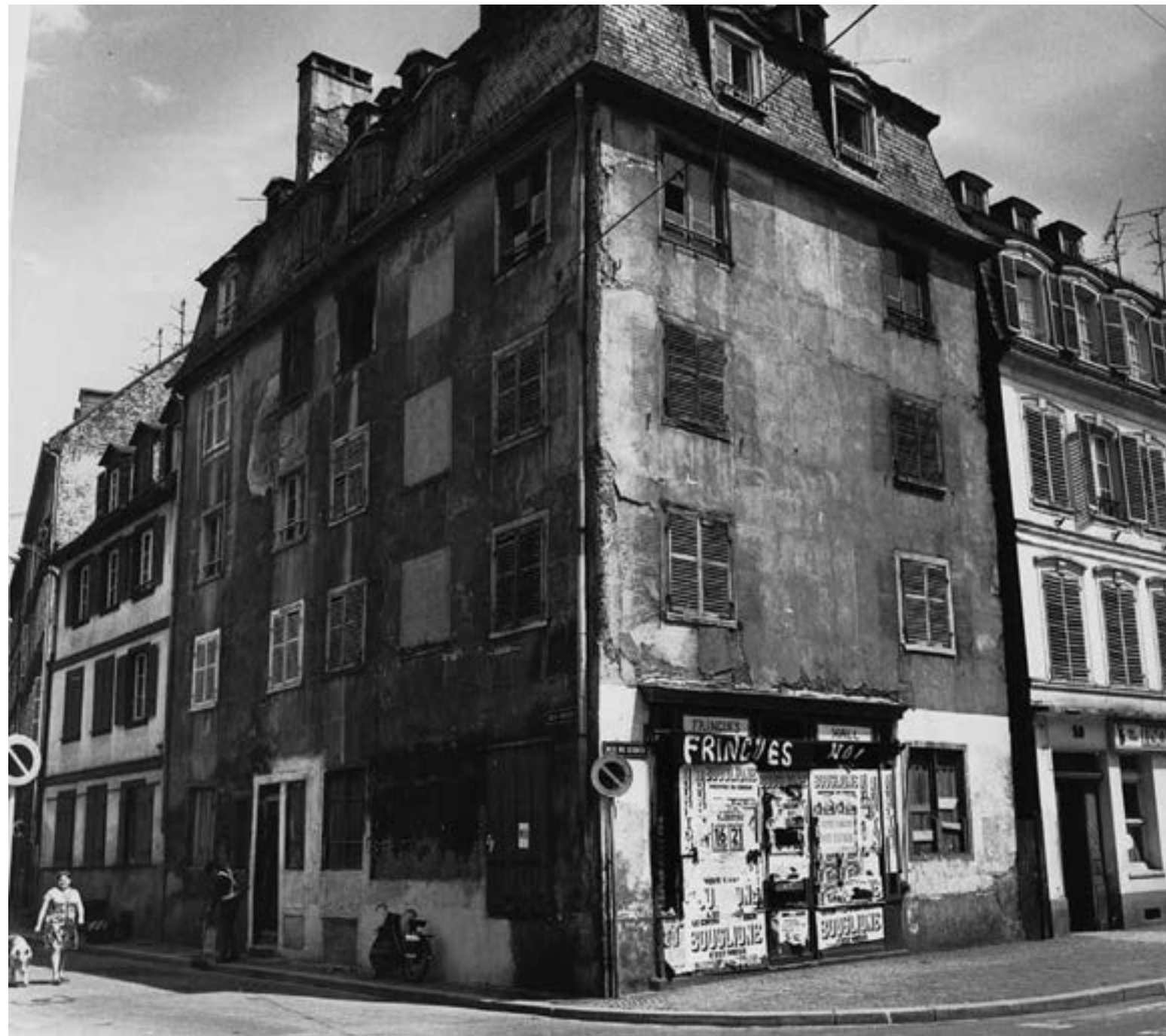
2 rue Fritz, vue sur le bâtiment avant réhabilitation. 1977-1978
