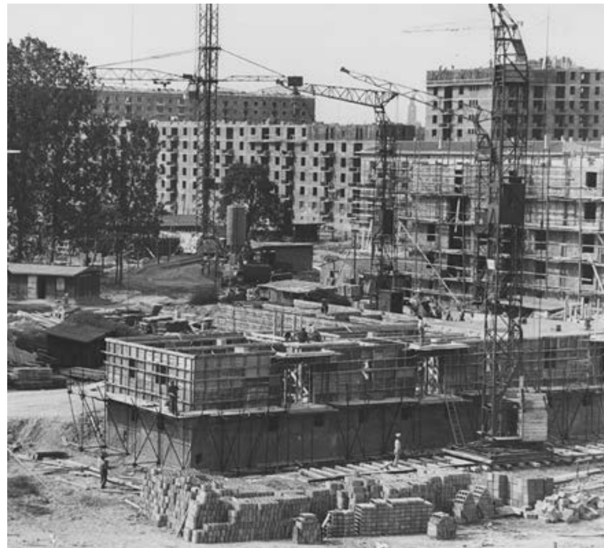
Cité de la Meinau, vue d'ensemble sur le chantier de construction. 1958
