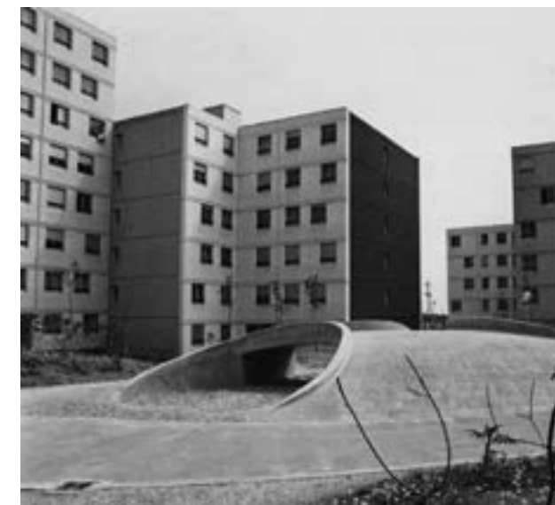
Maille Karine en fin de chantier, un pont dans une cour intérieure. 1975
