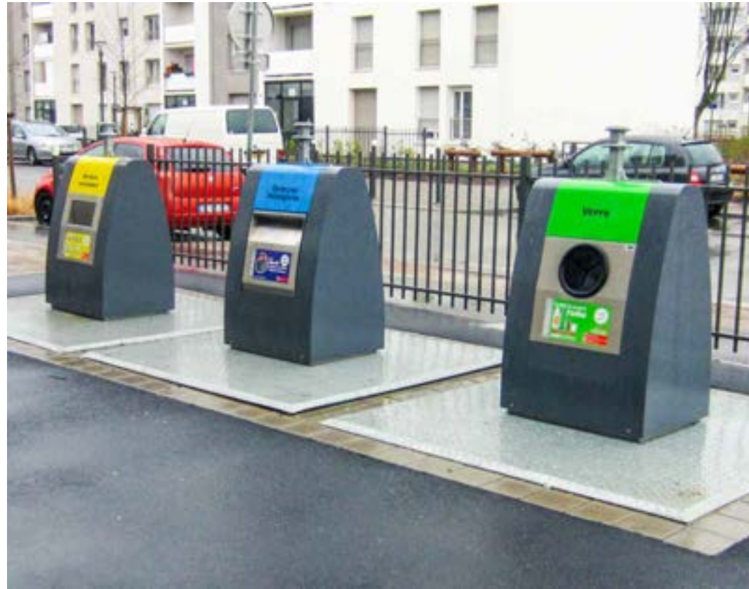
Aire de collecte enterrée des déchets
