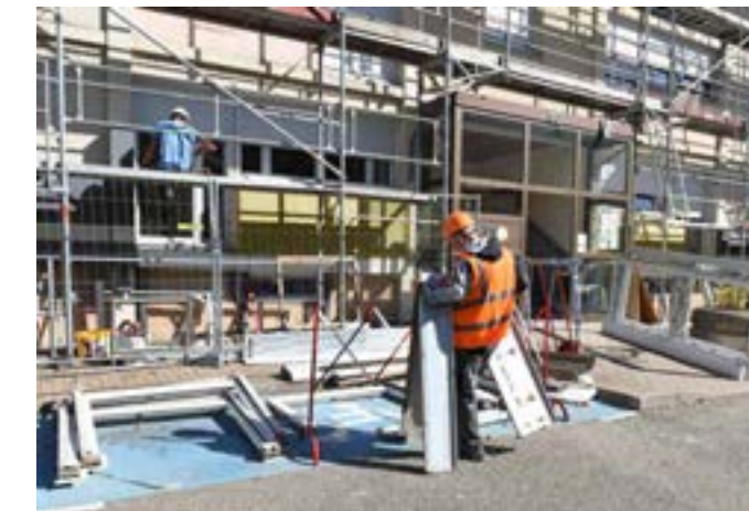
Chantier de réhabilitation. 2020
