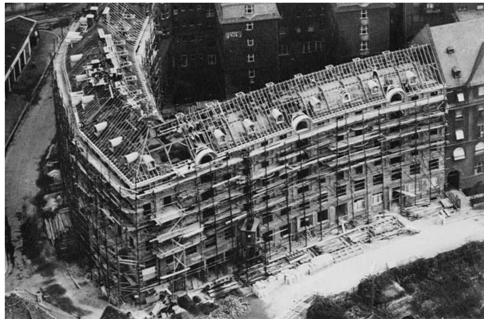
Vue aérienne du bâtiment en construction, angle de la rue de Genève et la rue de Lucerne. 1931-1936
