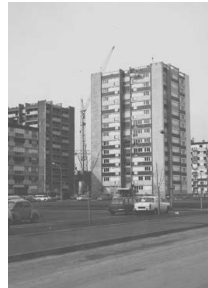
Cité Elsau II, vue d'ensemble pendant le chantier de construction. 1970
