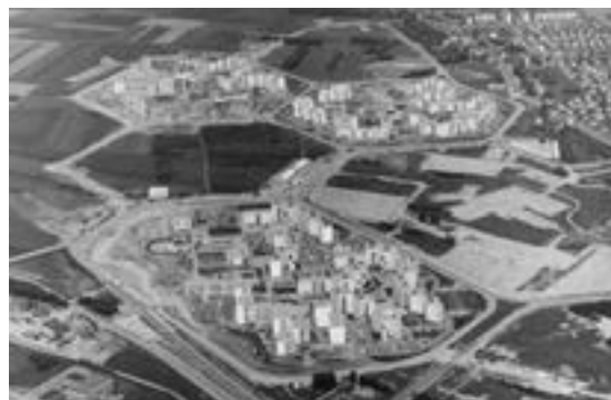
Cité Hautepierre : vue aérienne de la maille Éléonore en fin de chantier (au 1 er plan). 1971
