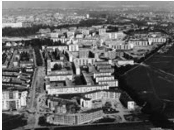
Vue aérienne du chantier de construction Neuhoef extension. 1964-1966
