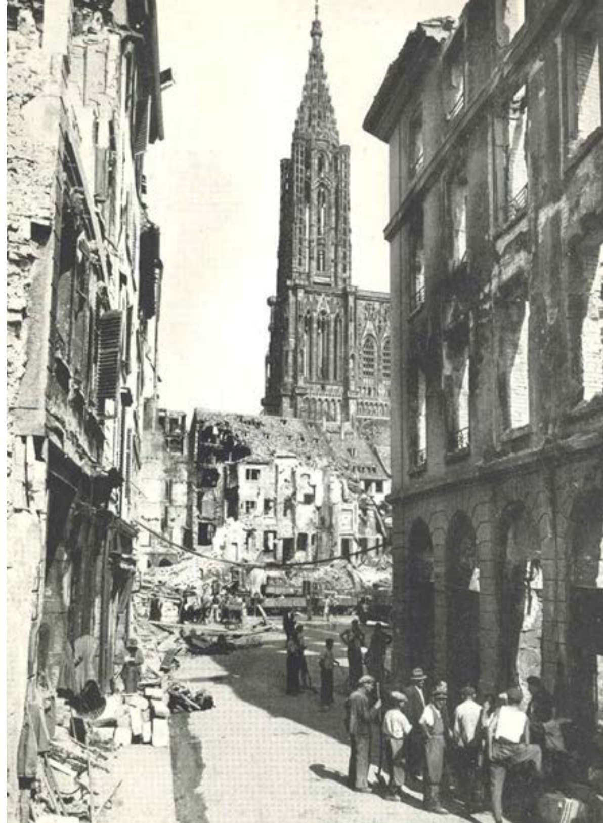
Bâtiments sinistrés au coeur de Strasbourg.
